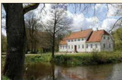
Lerbæk efter renovering. Den blev skilt ad sten for sten af entreprenørfirmaet Trigon - og derefter genopbygget i original udførelse.
